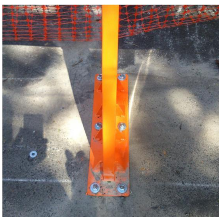
Figura 16 - Apoio instalado e fixo da Estação.
