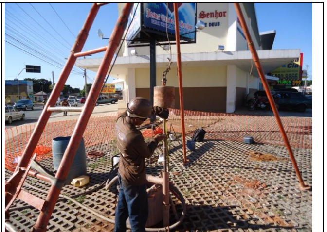
Foto. 02 – Detalhe da Sondagem à Percussão – SPT (Divisão do trecho em 45 cm)
