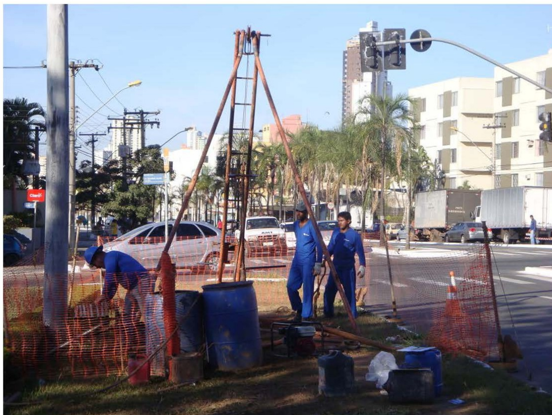
Figura 1 – Foto da execução da sondagem
