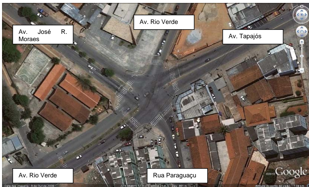
Foto 1- Interseção Avenida Rio Verde x Avenida Tapajós
