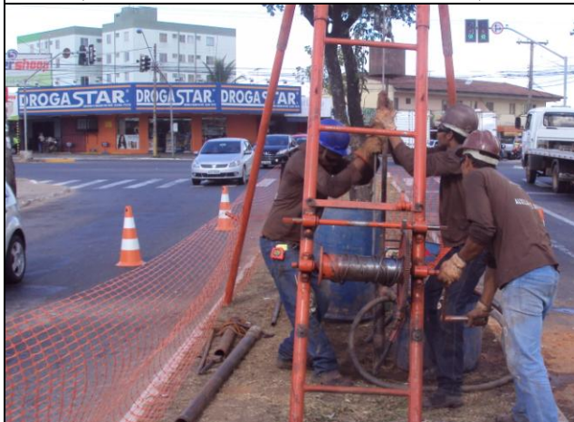
Foto. 03 – Detalhe da Sondagem à Percussão – SPT (Ensaio através do martelo de 65kg)
