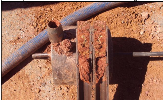
Foto. 05 – Detalhe da Sondagem à Percussão – SPT (Processo de Amostragem)
