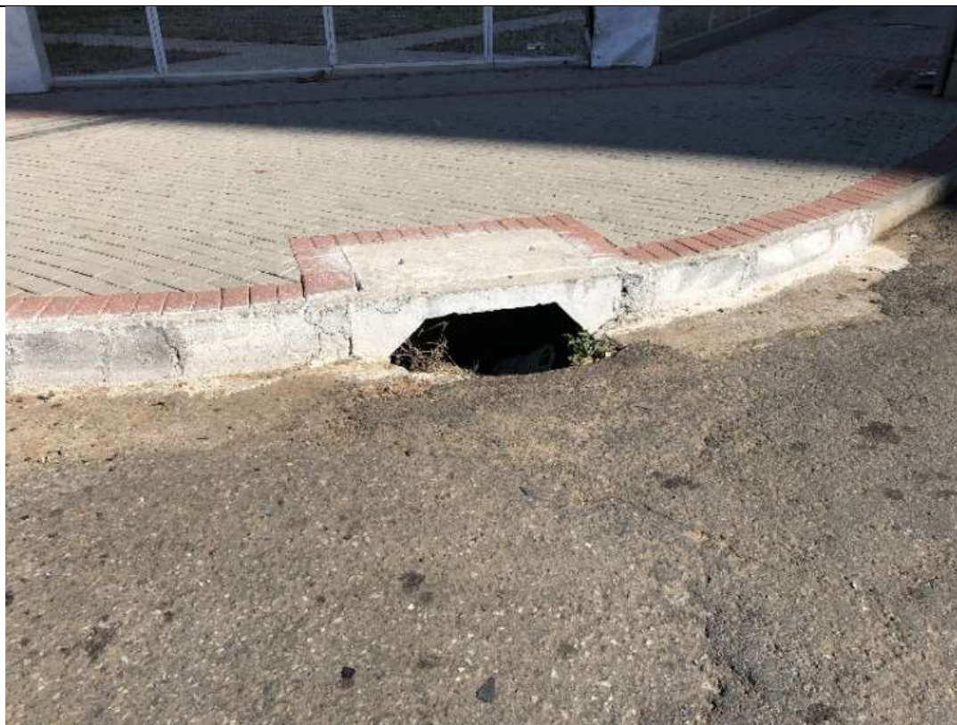
Figura 9 - Drenagem das águas pluviais ( rua T-55 com a T-27, Setor Bueno)
