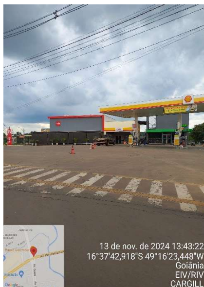
Figura 40: Posto de Combustível
