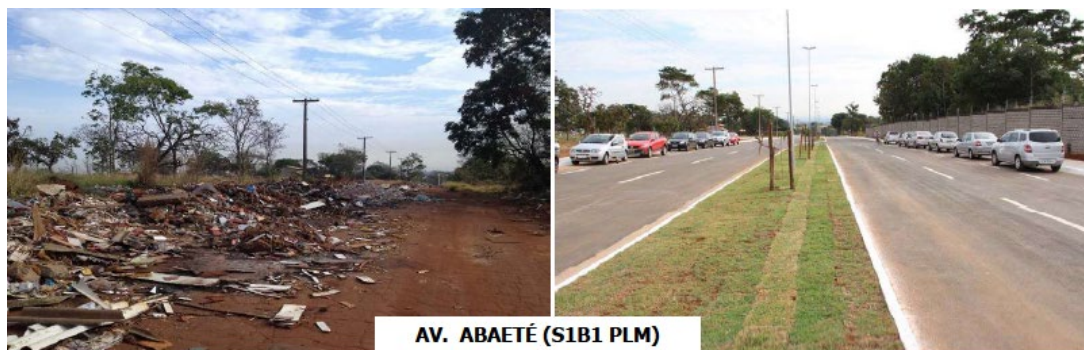
Figura 9 – Obras executadas – PUAMA I
