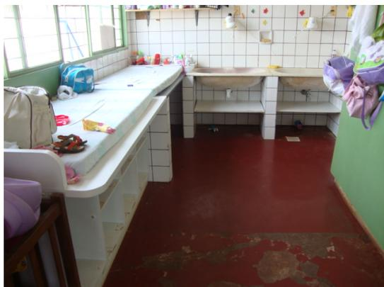
Foto 1 – Revestimento de cimento queimado a ser substituído.
