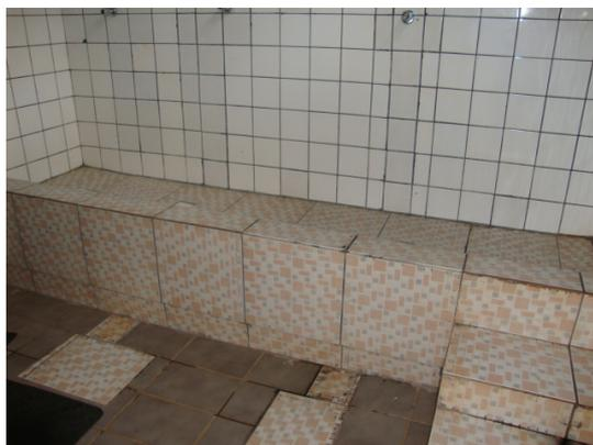
Foto 2 - Revestimento cerâmico a ser substituído.
