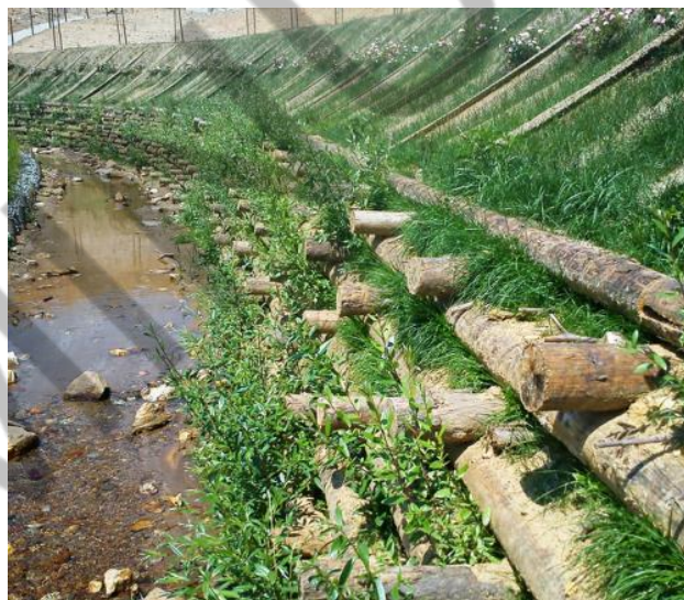
Figura 29 – Muro de suporte vivo em madeira tipo Cribwall (Fonte: Ecosalix).
