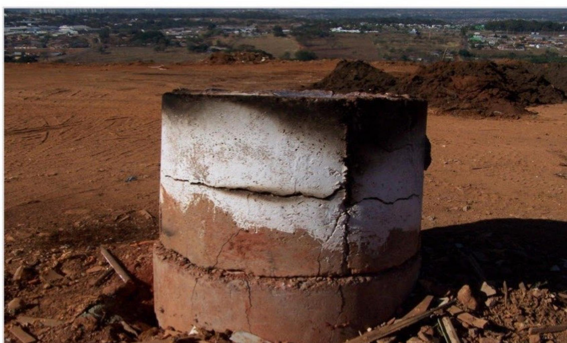
**Figura 9: Registro de um dos 18 queimadores de metano em operação no Aterro de Goiânia.**
