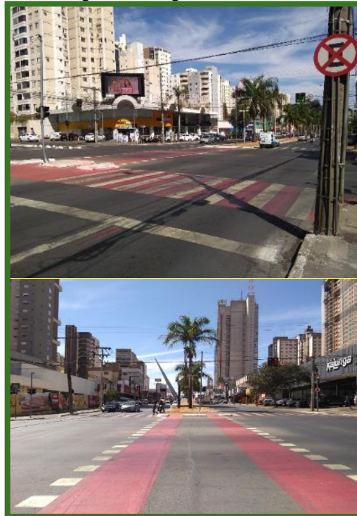
Figura 43 - Imagens do Corredor T-63
