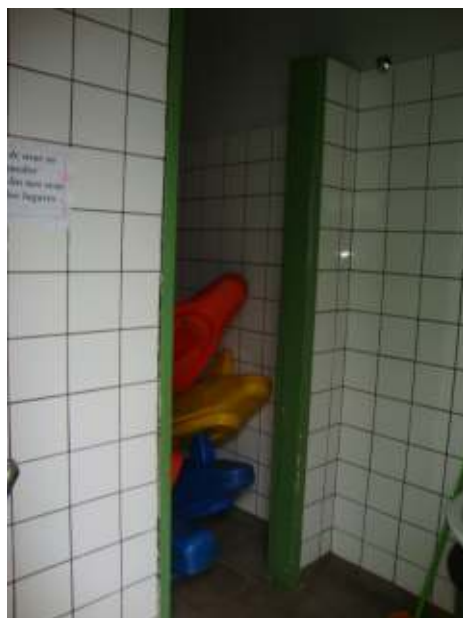
Foto 7 – Banheiro que será reformados para ampliação dos banheiros infantis.
