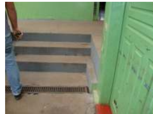
Foto 6 – Escada que será demolida para colocação de rampa.
