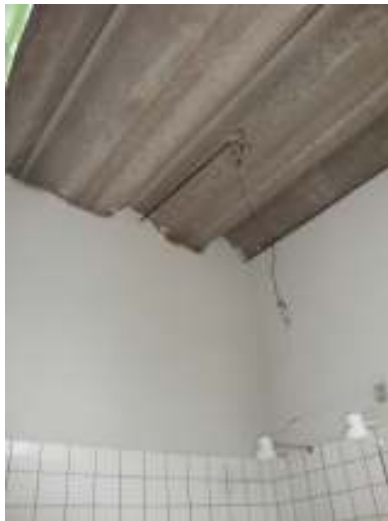
Foto 11 – Local onde será colocado o forro de PVC.
