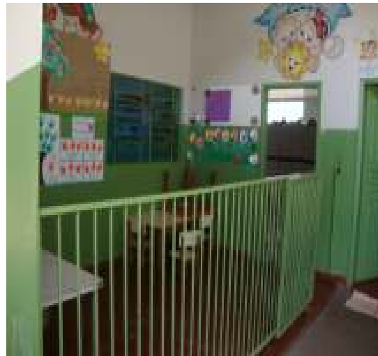
Foto 12 – Parede que será demolida para ampliar a sala de atividades.
