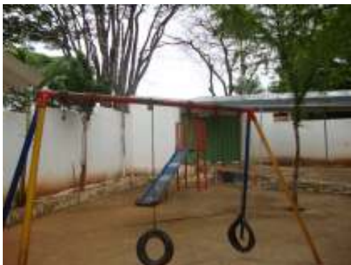
Foto 5 – Rampa da entrada que será reformada para promoção da acessibilidade.
