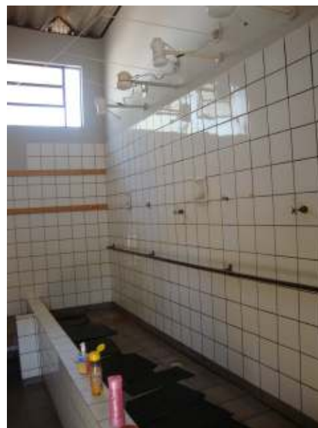
Foto 8 – Banheiro infantil que será reformado.
