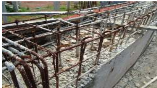
Foto estrutura executada
