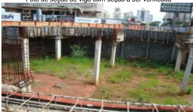
Foto da estrutura a ser aproveitada/adequada a novo projeto
