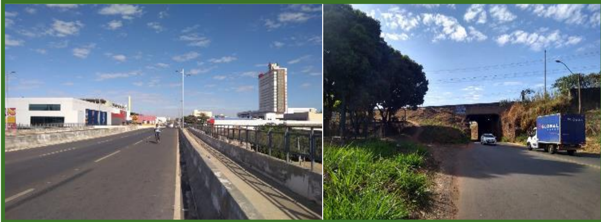
Figura 49 - Imagens do Corredor Leste-Oeste
