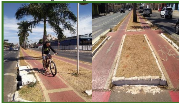
Figura 44 - Imagens do Corredor T 63
