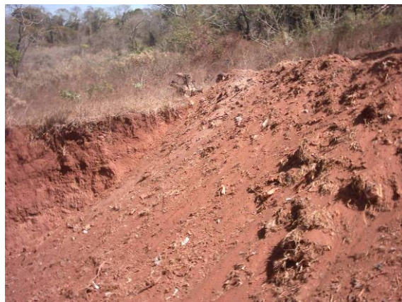
Fig. 4.11 – Processo de contenção por entulhos da erosão ao fundo do 13º batalhão.
