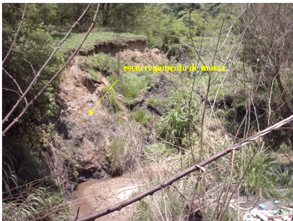
Figura 8.11: Imagem de processo de escorregamento de massa observado na erosão do Córrego Retirinho.
