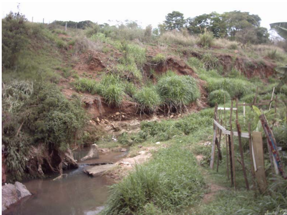
Figura 8.22: Erosão por solapamento da margem do Córrego Água Branca, observado no final da Rua Uruguai.
