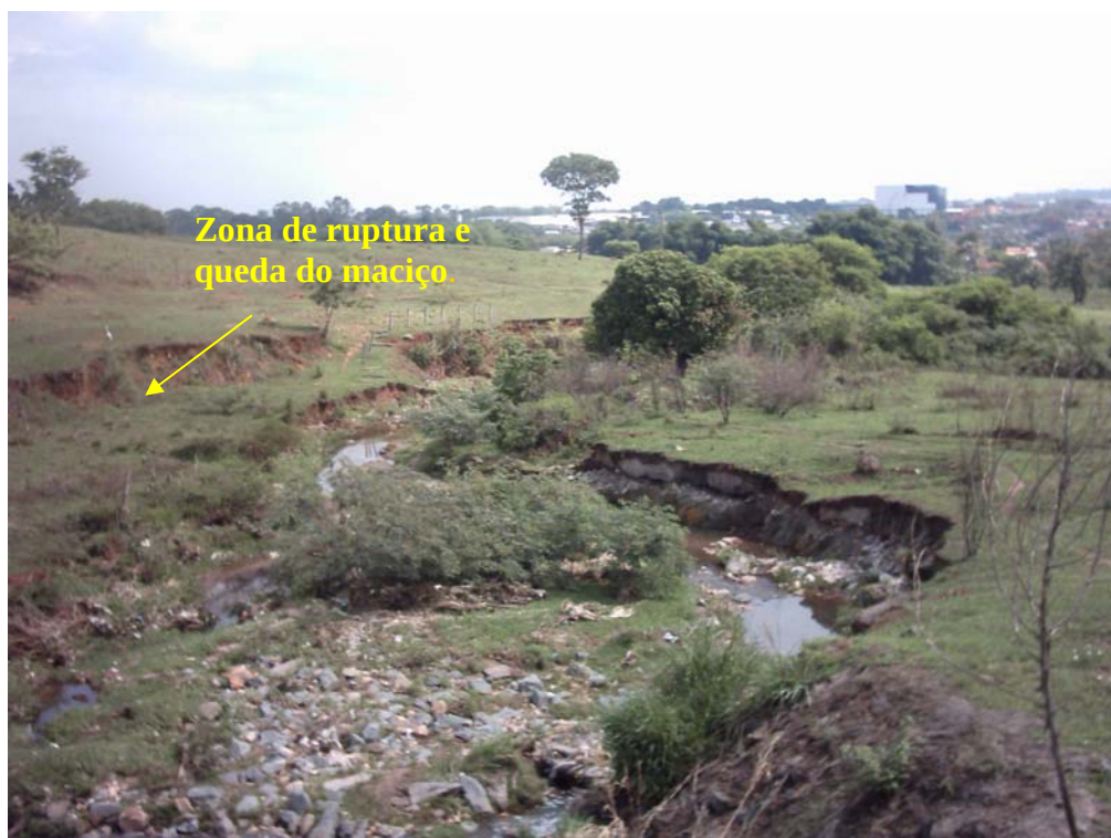
Figura 8.07: Uma visão panorâmica do mesmo local, de sul para norte, observando-se alguns trechos com ruptura e queda do maciço.
