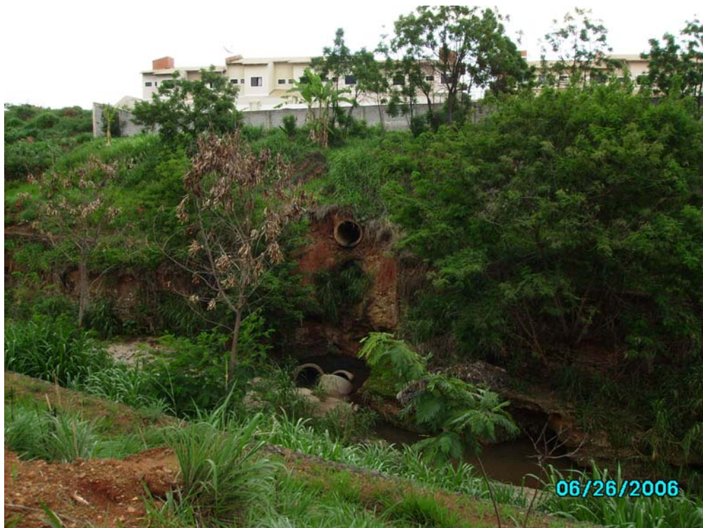
Figura 8.44: Outro ponto de erosão do Córrego Cascavel ameaçando casas de um condomínio residencial.
