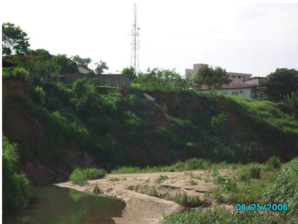
Figura 8.29: Erosão observada numa das nascentes do Córrego Cascavel na Alameda Ingá, no Parque Amazônia.
