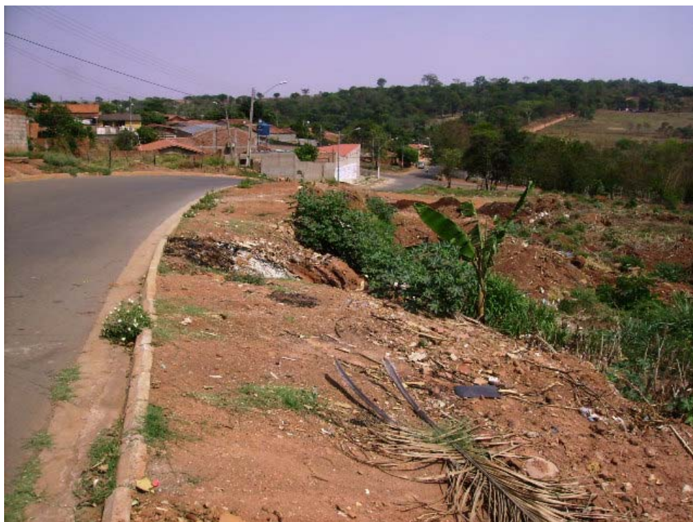
Figura 8.52: Processo erosivo instalado na região da Avenida Perimetral Norte, em área de relevo mais acidentado, observado no Setor Perim.
