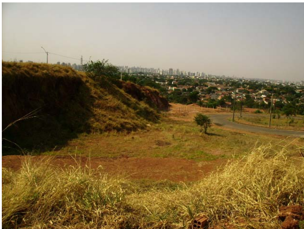
Figura 8.55: Corte executado nos solos líticos derivados de gnaisses granulíticos, com vista de Goiânia.
