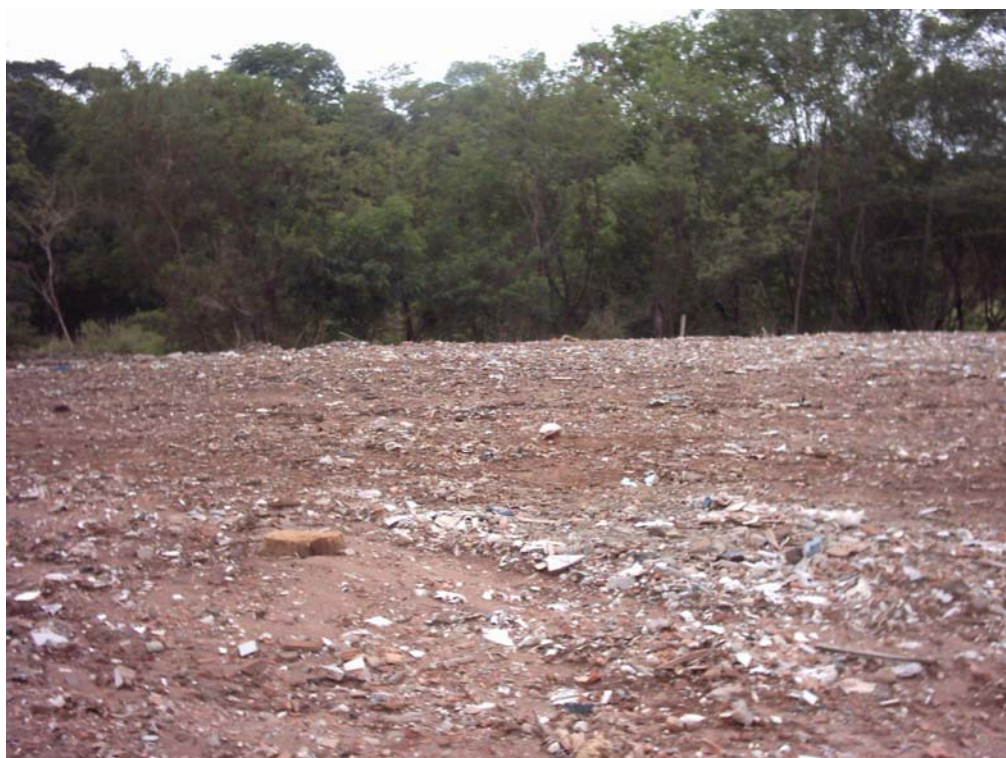
Figura 8.18: Entulho de materiais de construção civil lançado para conter erosão em frente à Chácara 35, da Rua Bogotá, Jardim Novo Mundo.
