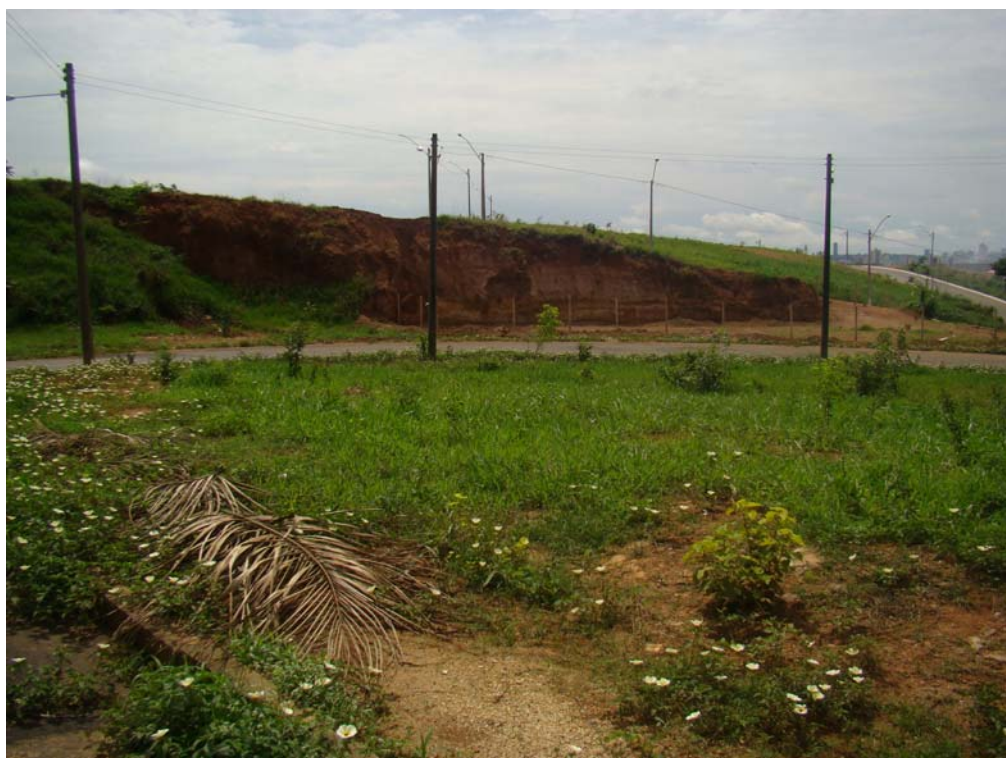
Figura 8.50: Erosão em solos derivados de gnaisses que ocorrem na região do Morro do Além, Setor Urias Magalhães.
