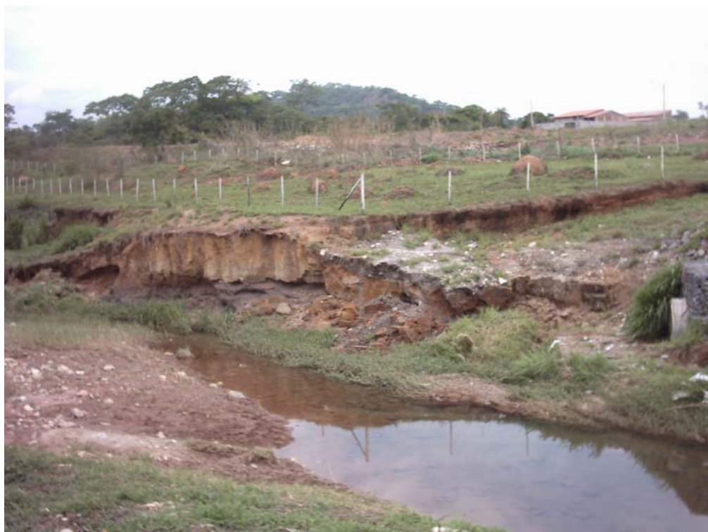
Figura 8.15: Erosão das margens do Córrego Água Branca, próxima a sua foz no Rio Meia Ponte. No alto da imagem uma elevação, testemunho do Planalto Rebaixado de Goiânia.
