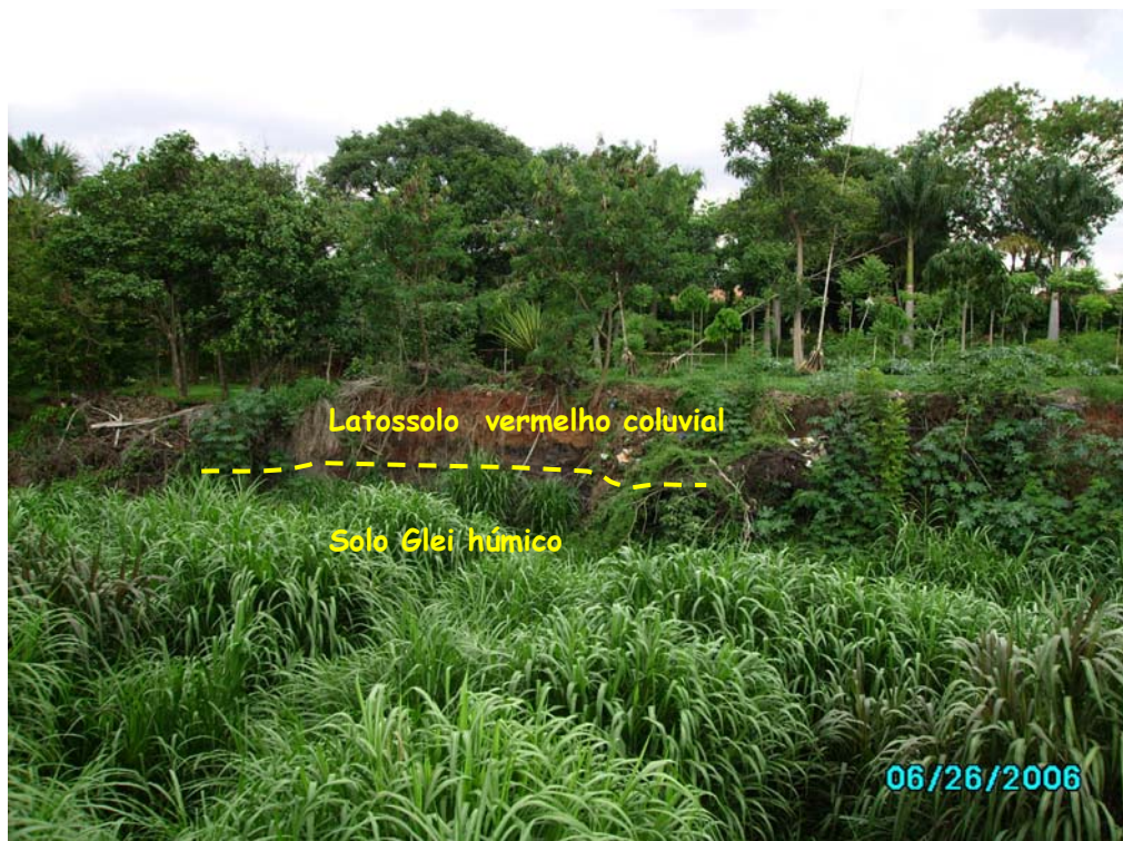
Figura 8.35: Erosão do Córrego Macambira, no fundo da Divisão de Parques e Jardins, em frente ao Residencial Veneza. Observar na imagem a ocorrência de latossolo vermelho, coluvial, sobre solos tipo Glei (cinza).
