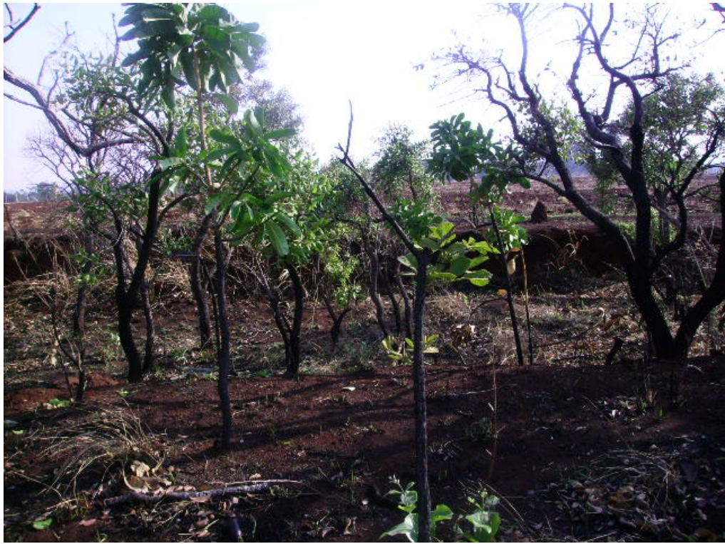
Figura 6.07: Processo erosivo em rochas do Complexo Granulítico Anápolis Itauçu, na GO-060.
