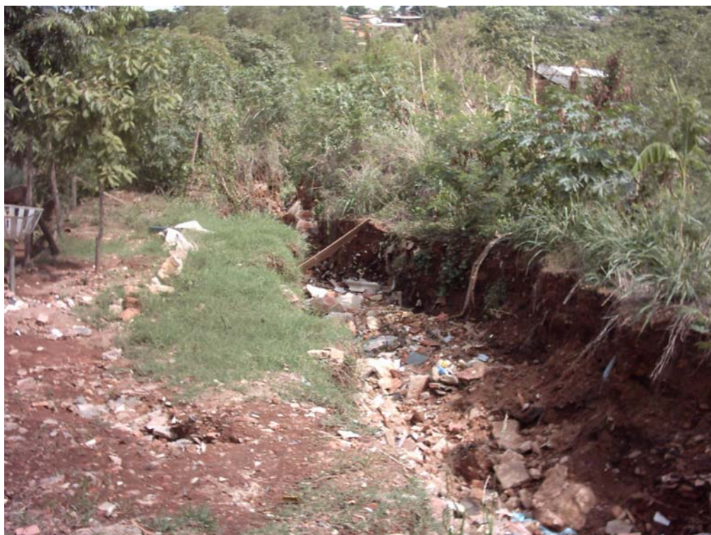
Figura 8.25: Ravinamento contido com entulho na nascente do Córrego Água Branca, na Rua Anápolis, Jardim Novo Mundo.
