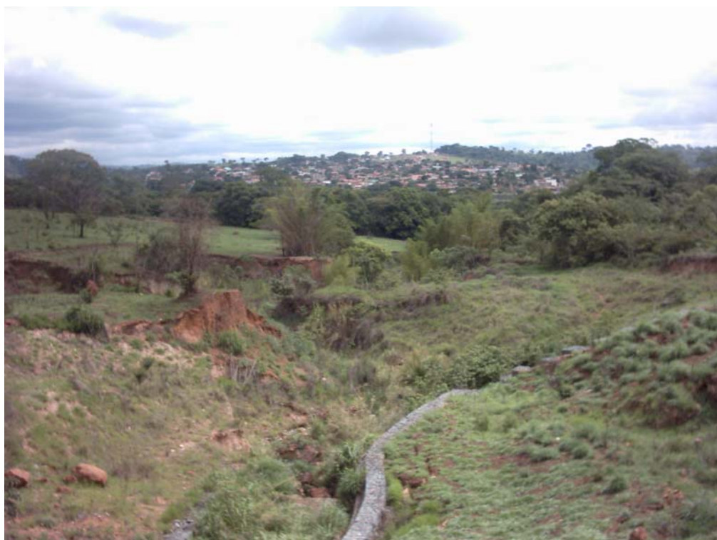
Figura 8.60: Trecho final da obra de contenção da erosão da região do autódromo, observando-se a retomada do processo no final do muro de arrimo.
