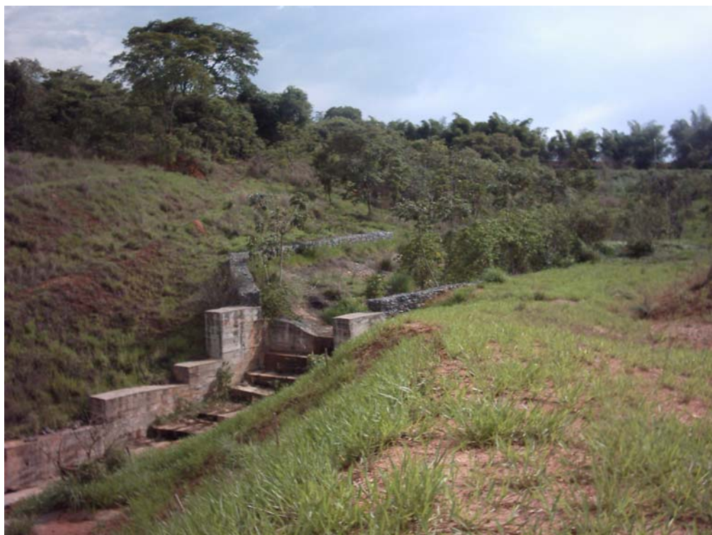
Figura 8.59: Obra de contenção bem sucedida, da erosão situada na Avenida Airton Senna, na região do autódromo.
