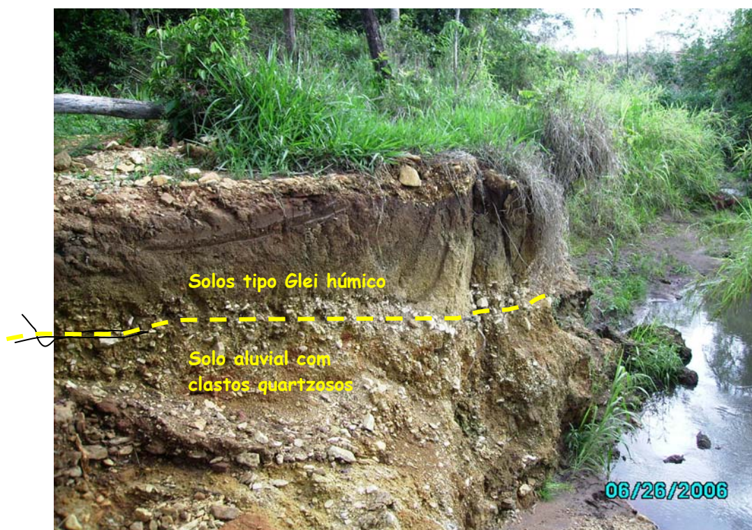
Figura 8.34: Erosão da margem do Córrego Capão do Mato, na região do Residencial Moinho dos Ventos, extremo sudoeste de Goiânia.
