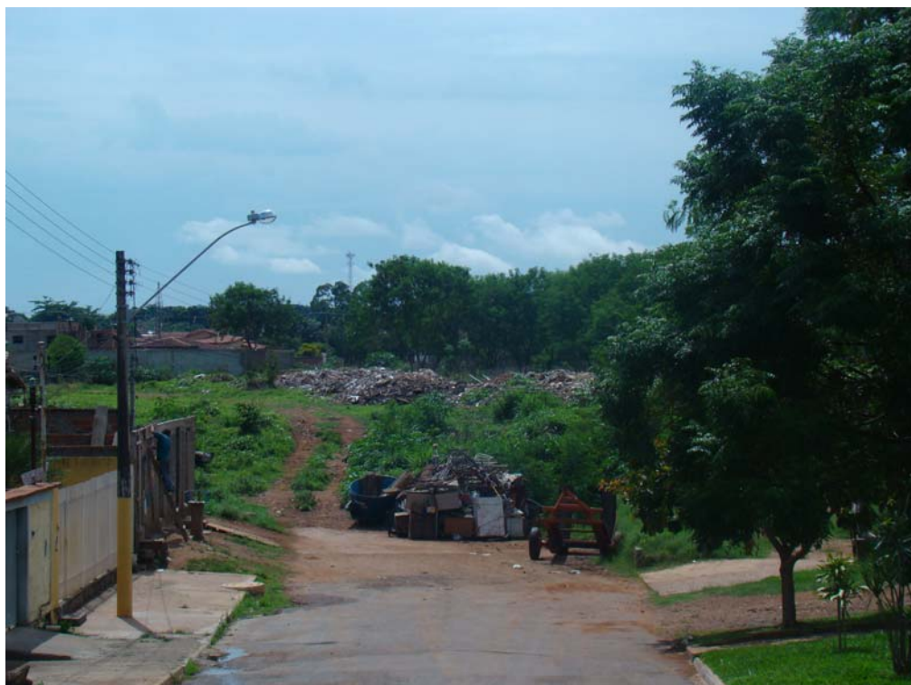
Figura 8.45: Depósito de lixo próximo à erosão no Ribeirão Anicuns.
