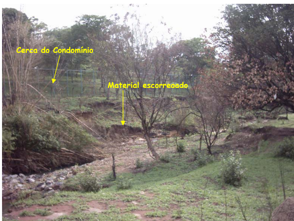
Figura 8.28: Erosão por solapamento do Córrego Vitória, em frente à ponte da Rua José Hermano, ao lado do Condomínio Privê dos Girassóis.
