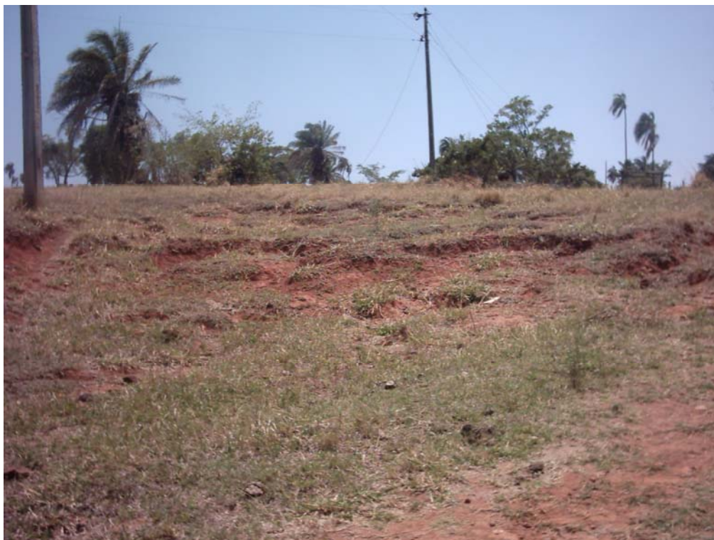
Figura 2.16: Uma vista panorâmica da ruptura do maciço, observada na região norte da MZ do Lajeado.
