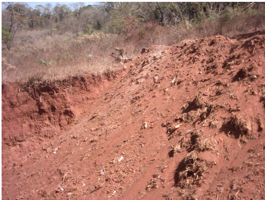
Figura 5.06: Processo de contenção por deposição de entulho da erosão ao fundo do 13º batalhão.
