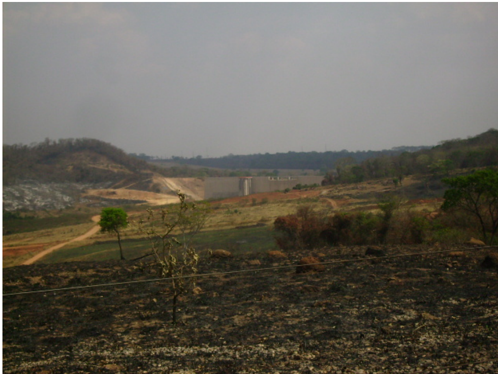
Figura 3.05: Em primeiro plano formas rampadas de baixa declividade desenvolvidos em gnaisses ortoderivados e ao fundo morros desenvolvidos sobre quartzitos. Ao centro a barragem do Ribeirão João Leite, em construção.
