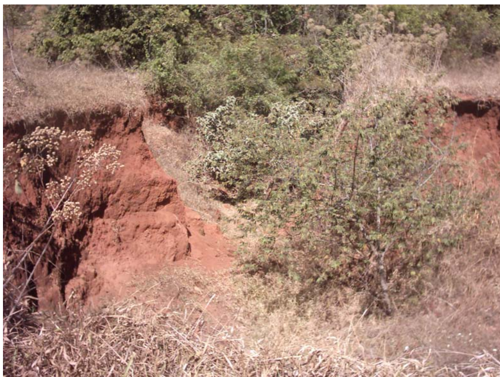
Figura 5.08: Outro ponto de erosão paralelo à erosão principal citada nas fotos anteriores.
