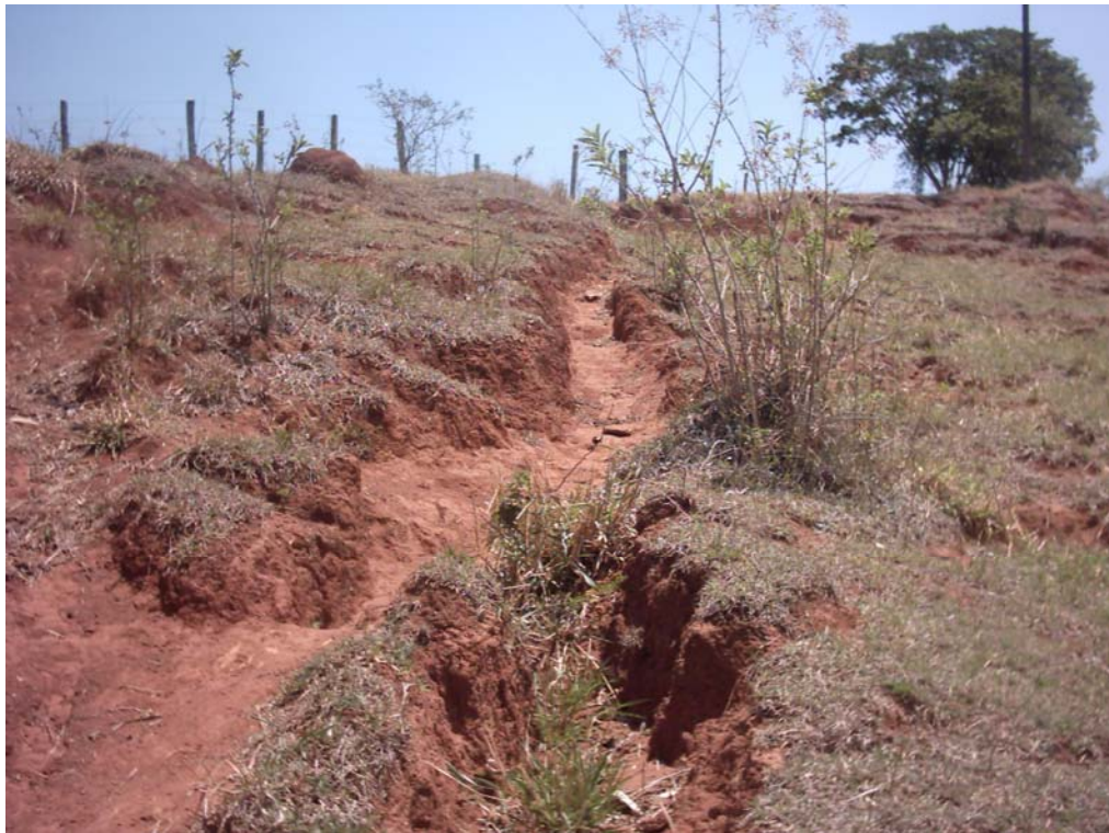
Figura 2.13: Processo de sulcamento pela passagem do gado, que tem como resultado a infiltração das águas pluviais com posterior ruptura do maciço.
