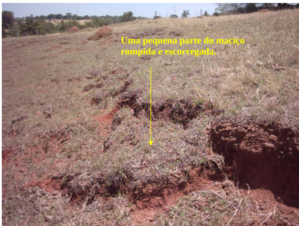
Figura 2.15: Detalhe da ruptura do maciço, observada na região norte da MZ do Lajeado.
