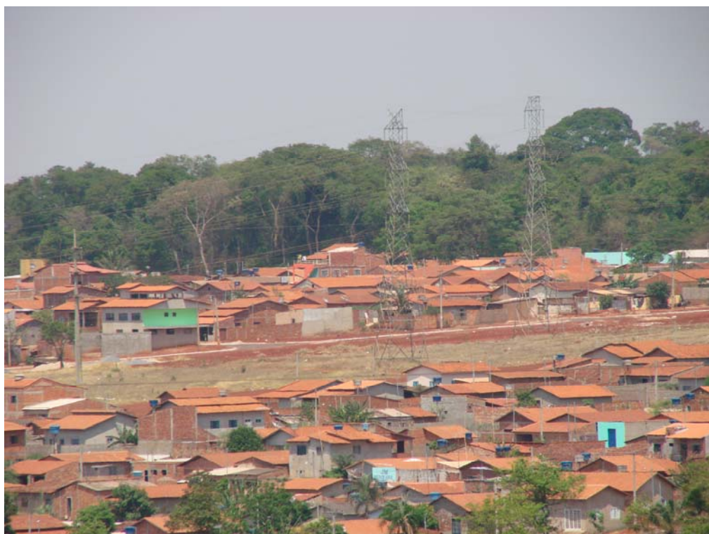
Figura 3.33: Imagem de Mata Seca nas proximidades do Setor Vale dos Sonhos (JLT-181).
