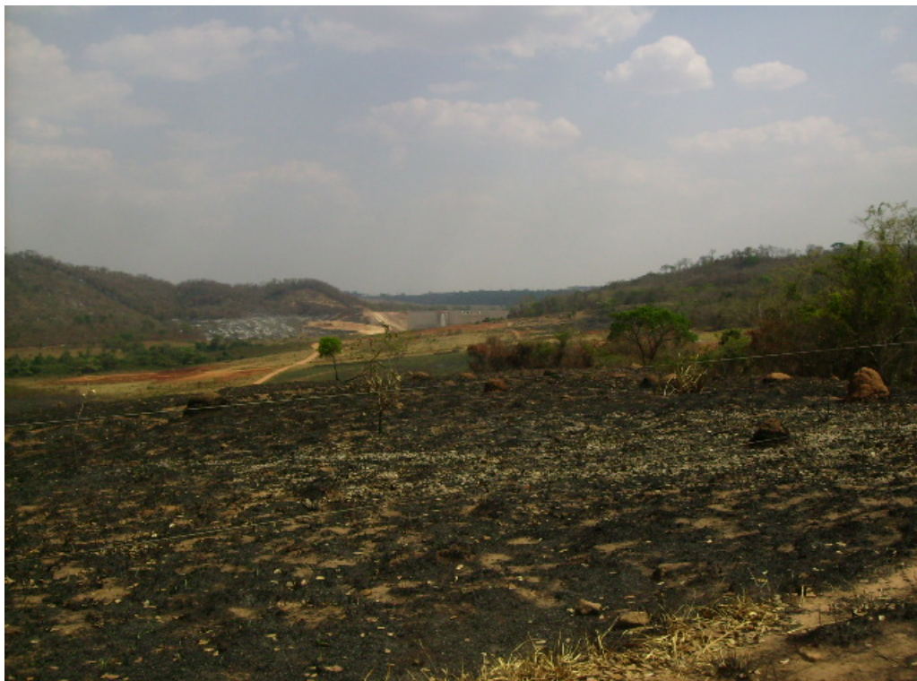
Figura 3.04: Em primeiro plano formas rampadas de baixa declividade desenvolvidos em gnaisses ortoderivados e ao fundo morros desenvolvidos sobre quartzitos. Ao centro a barragem do Ribeirão João Leite, em construção.
