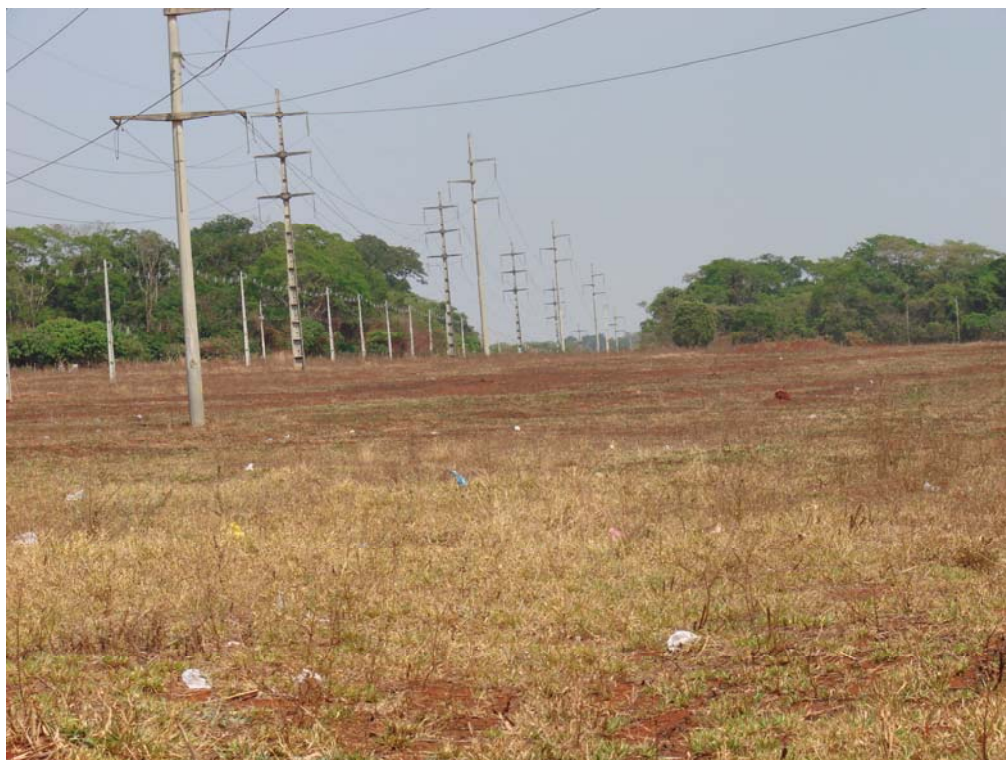
Figura 5.31: Imagem de uma mata seca interrompida por linha de transmissão de energia de alta tensão, sendo a área particular (SDG-206).
