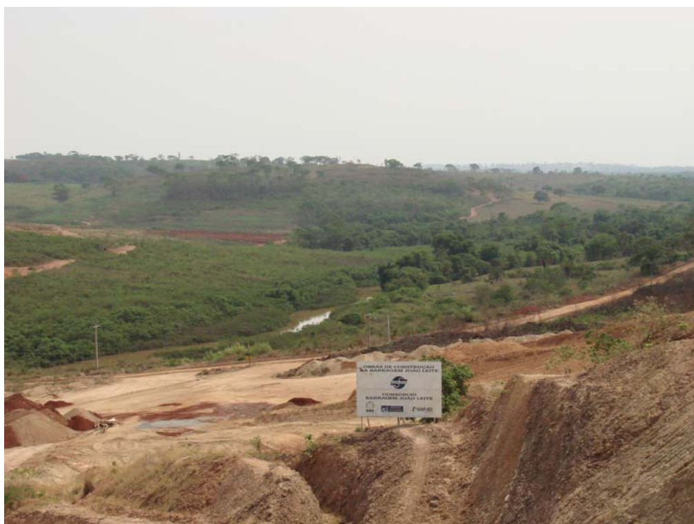
Figura 3.35: Imagem de parte da área a ser inundada pelo enchimento do reservatório de água do Ribeirão João Leite (JLT-268).
