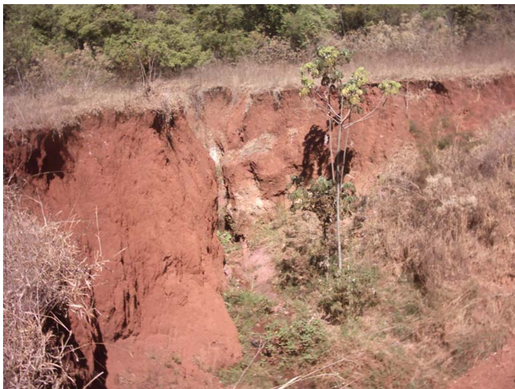
Figura 5.05: Processo erosivo observado ao fundo do 13º batalhão.
